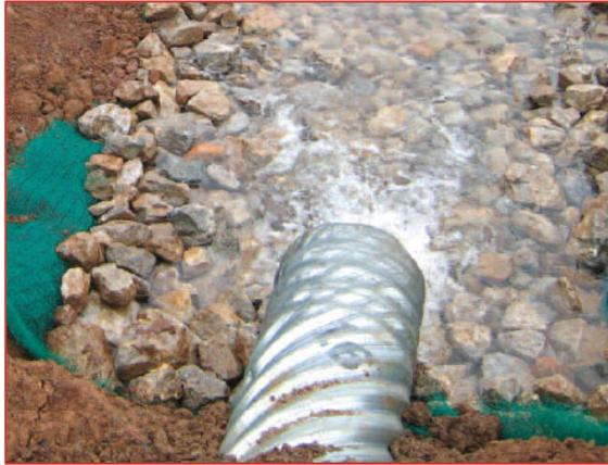
Le dispositif doit être choisi en fonction de leur capacité à résister à l'érosion, du potentiel érosif du sol, du débit, de la pente, des enjeux en aval, de la place disponible et de la durée du rejet.
